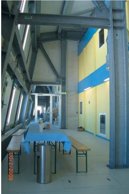
Abb. 4: Auf Höhe Deck 1 zwischen der Außenhülle (links) und den in zwei Ebenen montierten Modulen (rechts) steht weitere geschützte Nutzfläche zur Verfügung (Foto: H. Gernandt, AWI).
