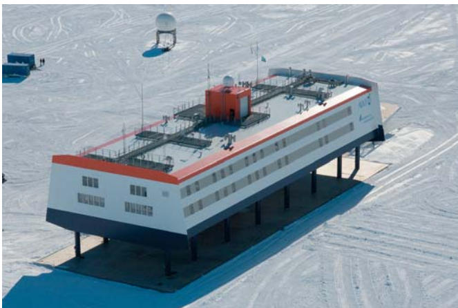
Abb. 5: Auf dem Dach des Gebäudes (Deck 3) befindet sich die Ballonfüllhalle. Wissenschaftliche Instrumente und Antennen sind auf den Gitterrosten und an den Geländern montiert. Im Hintergrund steht das Radom mit der Satellitenantenne für die Standleitung (Foto: realnature).
